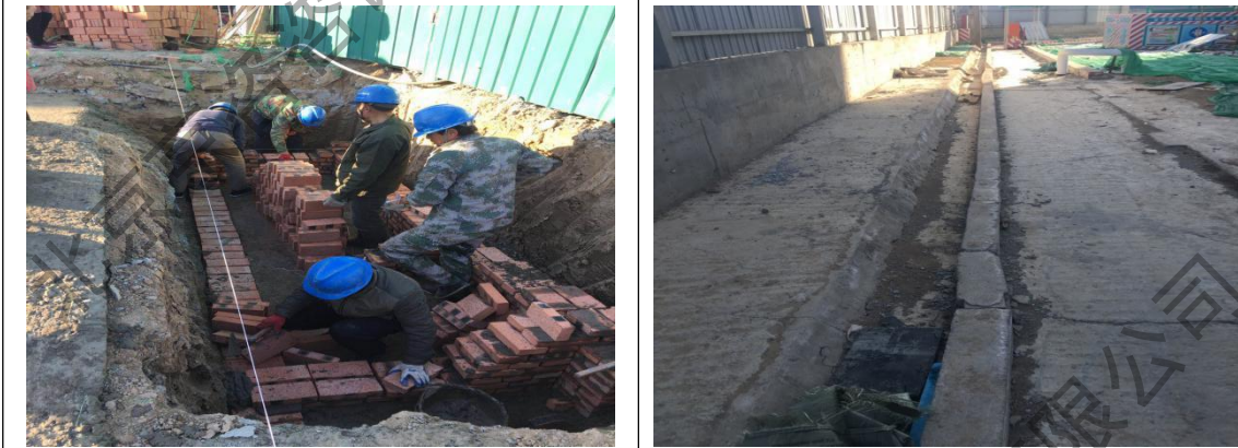
砖砌沉沙池及排水沟
