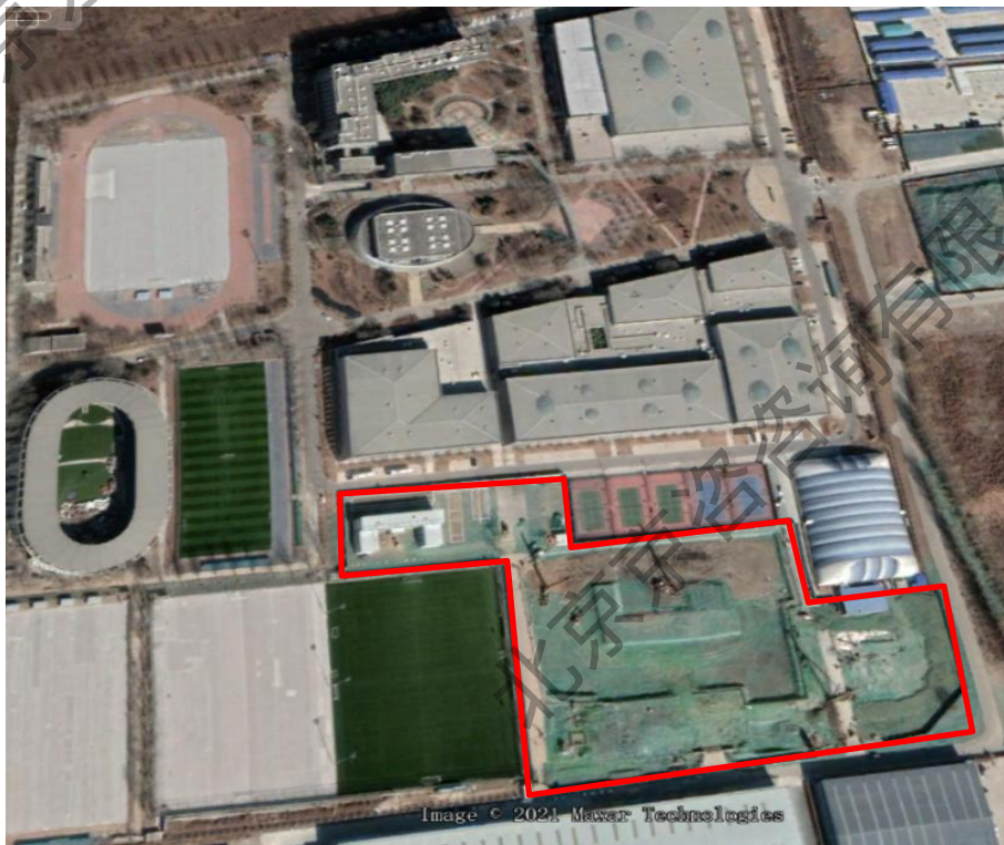
图 5-2 项目区施工影像图（2019 年 2 月）
