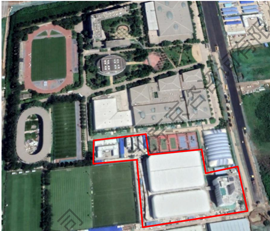
图 5-3 项目区施工影像图（2020 年 8 月）
