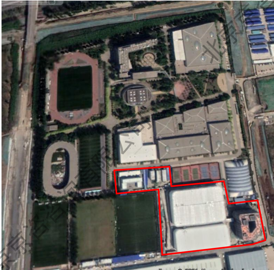
图 5-3 项目区施工影像图（2020 年 4 月）
