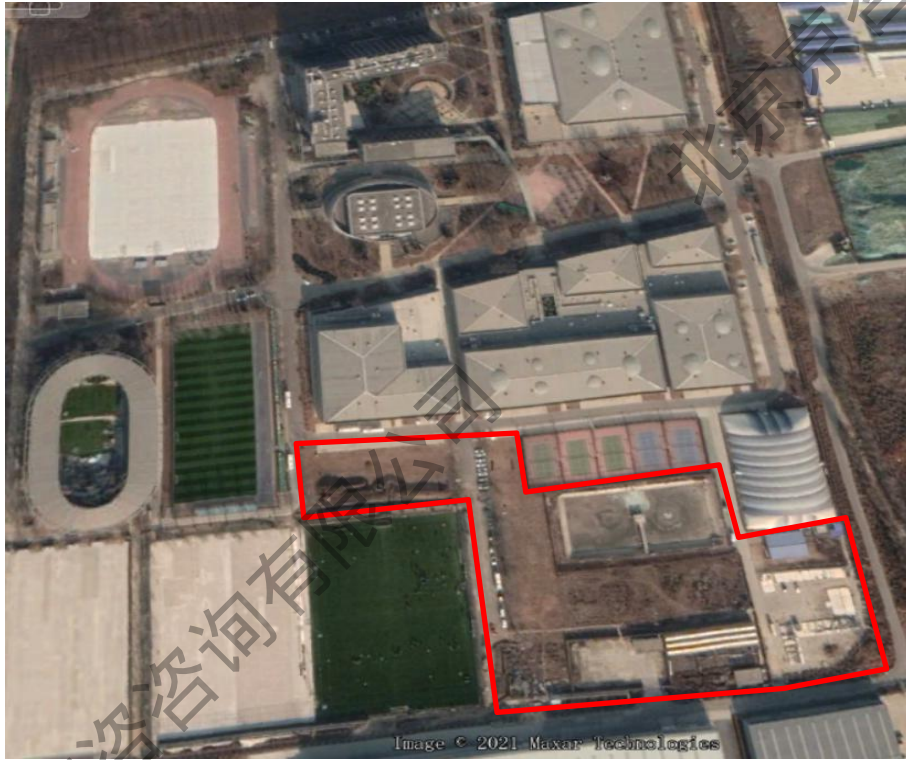
图 5-1 项目区施工影像图（2018 年 12 月）
