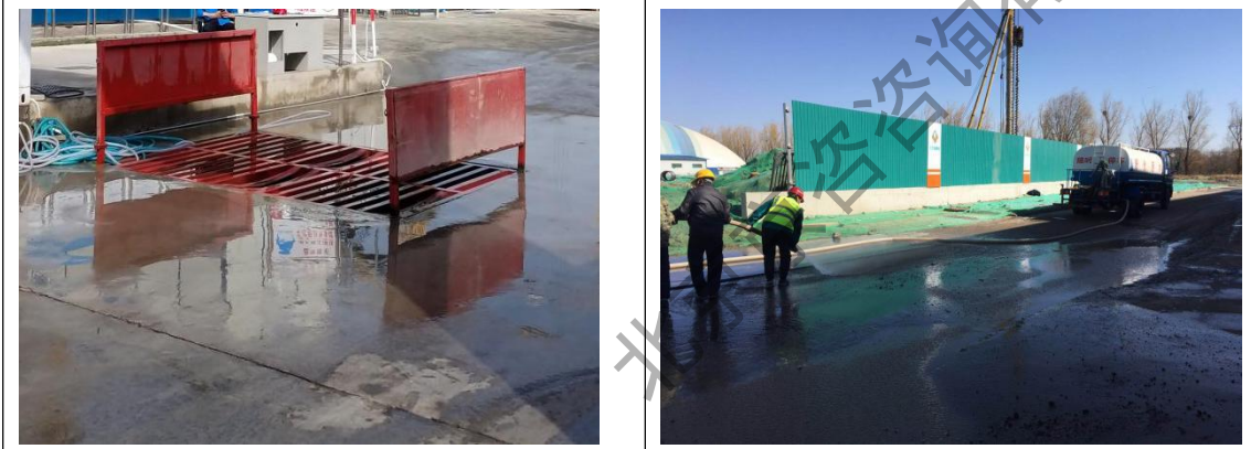
洒水降尘及临时洗车池
