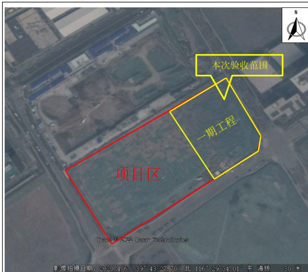
建设前影像图 (2020 年4月)
