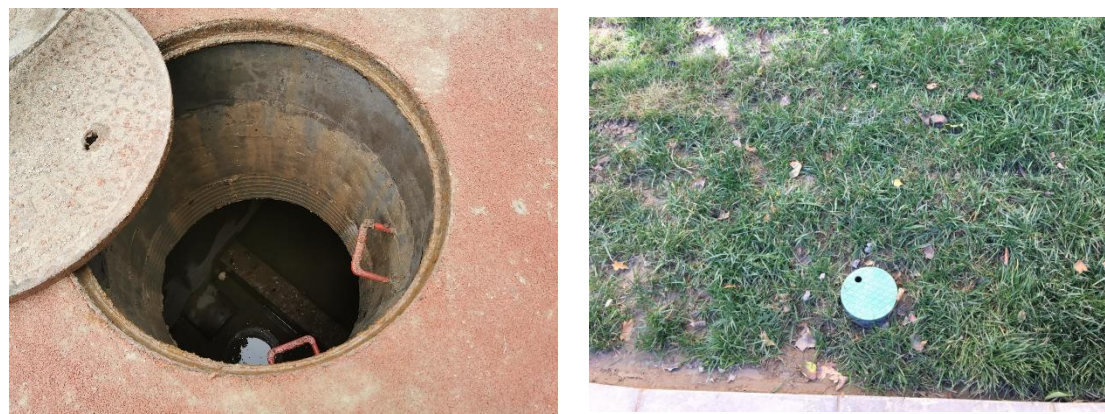
图 3-13 雨水调蓄池和节水灌溉
