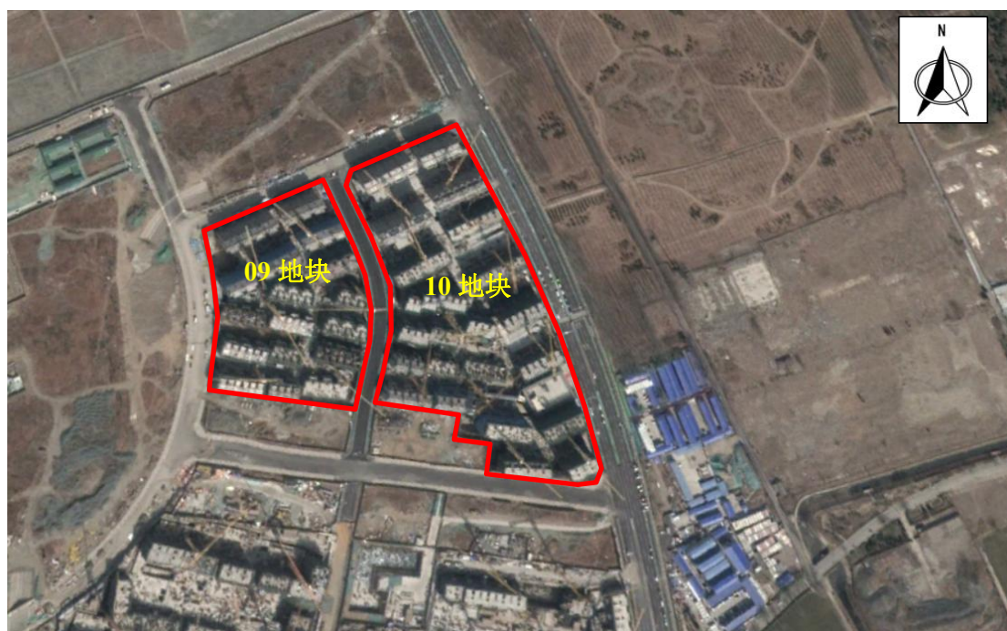
图 5-4 项目区施工影像图（2020 年 3 月）
