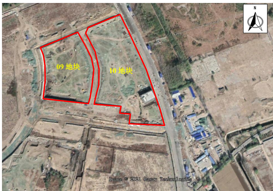
图 5-2 项目区施工影像图（2018 年 10 月）
