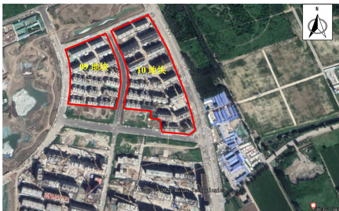
图 5-5 项目区施工影像图（2020 年 8 月）
